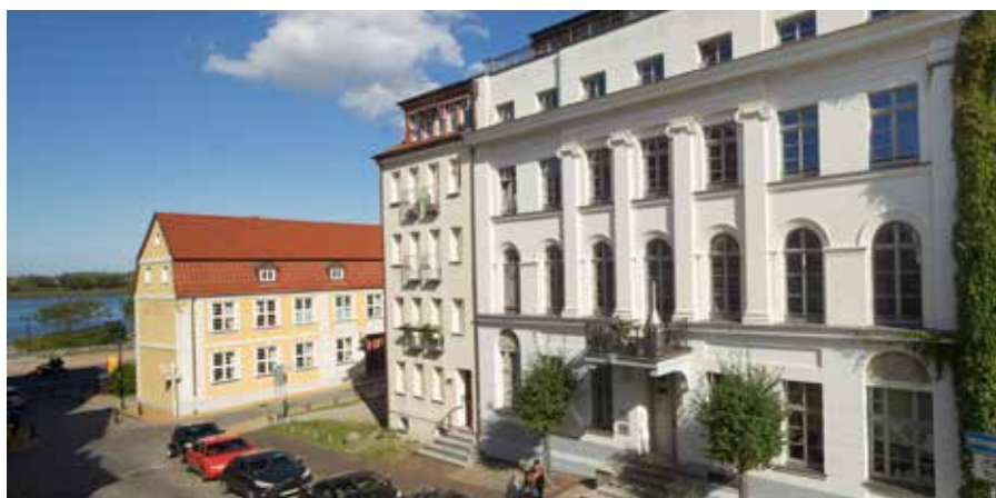
Nördliche Altstadt, Kossfelderstraße
